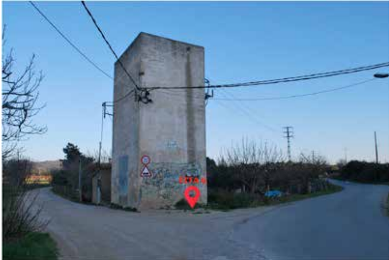
Fita 6. Ubicació al transformador del Figuerar. Autor: Pere Llauradó, 2023
